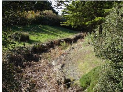
Ruisseau de la Normandelière (partie aval canalisée, située sous emprise)
